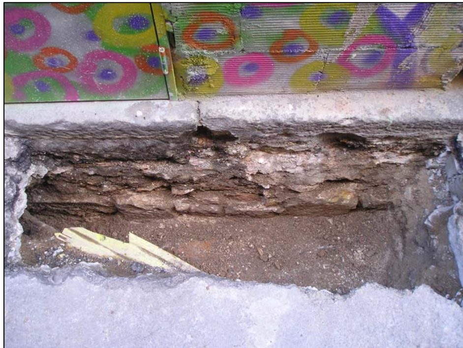
Banqueta de fonamentació del mur de façana al carrer Jupí.
