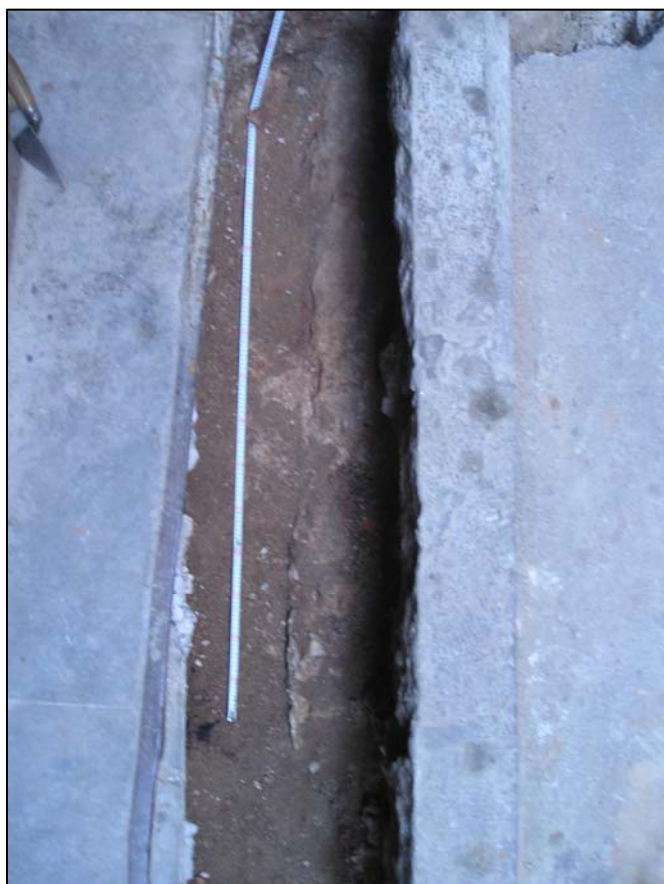
Restes de fonamentació del mur de façana davant el número 8 del carrer Jupí.
